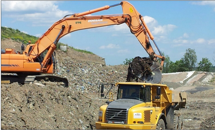
Ein Dumper lädt Material für die unterste Ausgleichsschicht ab
