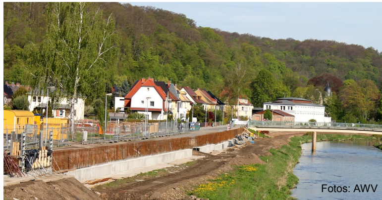
oben: Bau der Hochwasser-Schutzmauer entlang der Tschaikowskistraße unten: Deponie Untitz - Ostfeld wird rekultiviert
