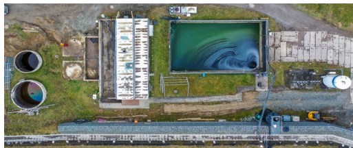
Sickerwasseranlage vor Umbau
