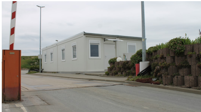
Neues Waage- und Sozialgebäude
