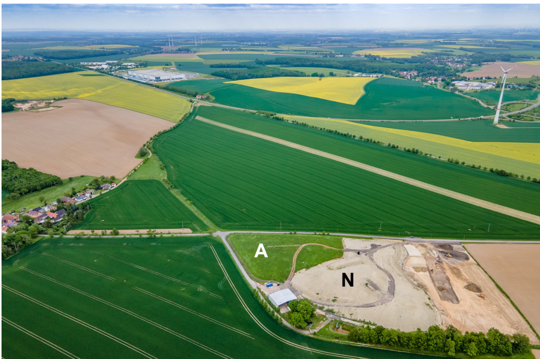
Auf der Sonderabfalldeponie in Gera-Aga werden derzeit Baumaßnahmen durchgeführt (siehe Luftbildaufnahme unten rechts). Mit den Bauarbeiten wird aktuell eine Grundlage für die Endprofilierung und vollständige Abdichtung der Deponie geschaffen.
