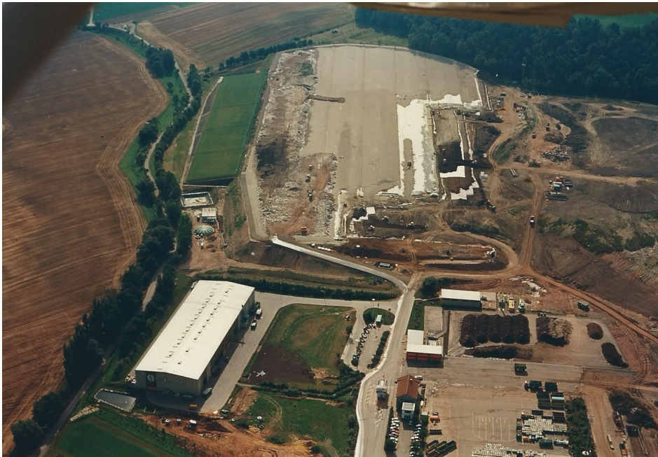
Abbildung 6.5: Aufbringung der Zwischenabdichtung auf dem Ostfeld (1997)
