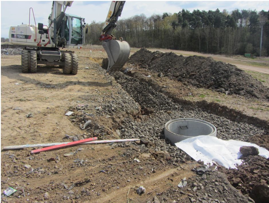
Abbildung 6.19: Bau der Versickerungsschächte und Rigolen (2012)
