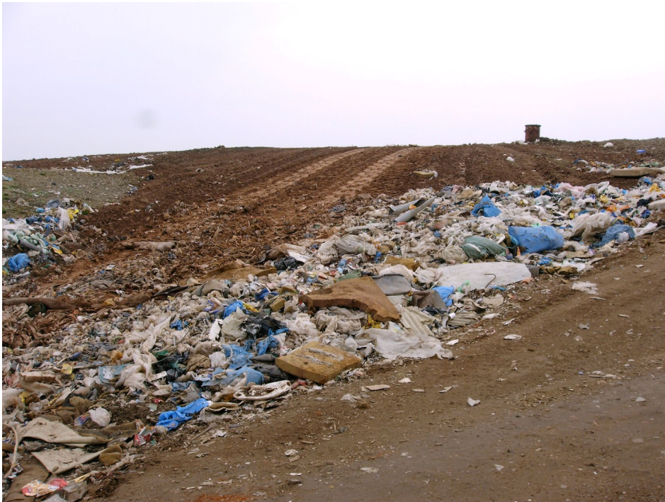
Abbildung 6.11: Dokumentation abgelagerter Abfälle (2005)
