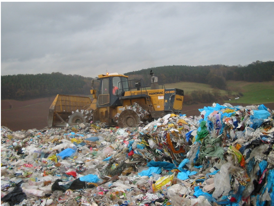
Abbildung 6.10: Einbau von Abfällen mittels Kompaktor (2004)
